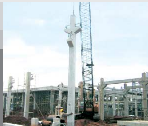
■ Kolom Pracetak PC Pipe Racks
