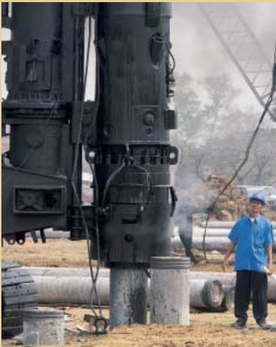
■ Pemasangan Tiang pancang bulat Spun piles Installation
