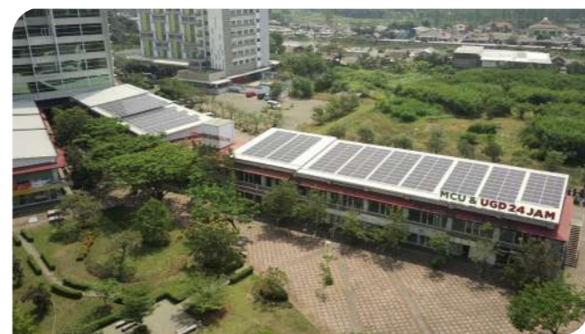
PANEL SURYA PADA THE PROMENADE, SURYACIPTA SOLAR PANELS AT THE PROMENADE, SURYACIPTA
