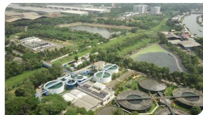
PANEL SURYA PADA WWTP ORGANICA, SURYACIPTA SOLAR PANELS AT WWTP ORGANICA, SURYACIPTA
